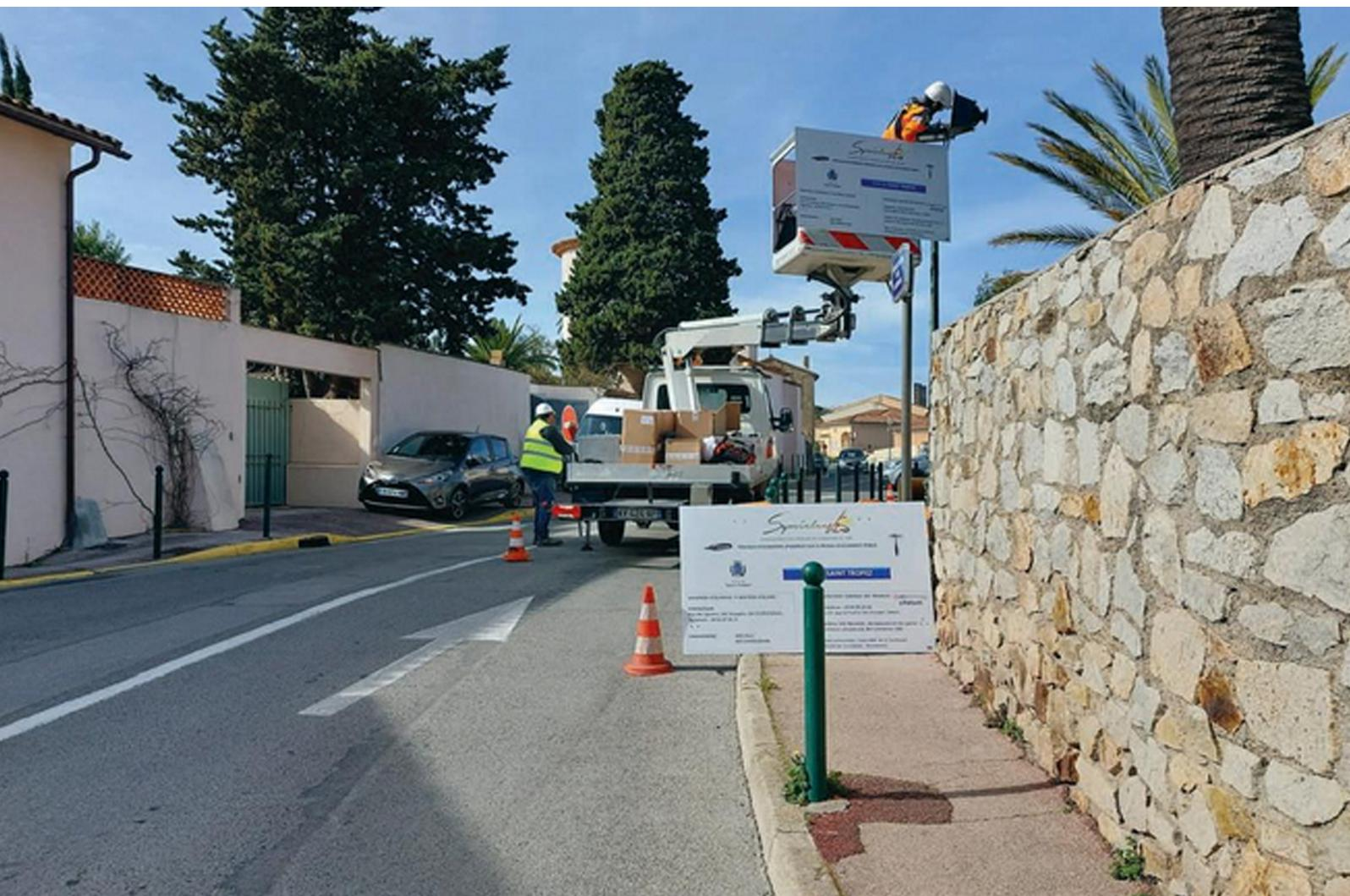
Dans le Var, à la demande de Saint-Tropez, TE83 a installé des caméras sur le parking de la ville, alimentées par l'éclairage et directement connectées.
