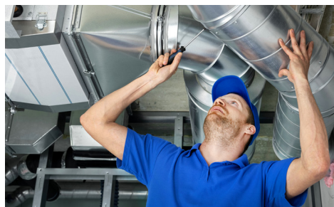
Intervention sur circuit de ventilation
