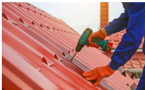
Réfection de toiture pour éviter les infiltrations
