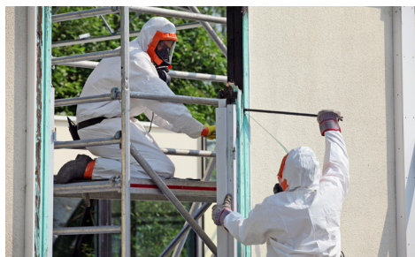
Opération de désamiantage
