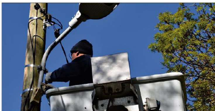
De nouveaux luminaires installés sur le chemin des Vignarets. (Photos A. L. R.)
