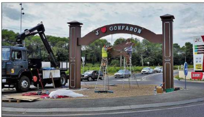
Philippe Rozack, des services techniques (gilet jaune) et l'équipe de « La Belle forge », ont terminé, jeudi, de structurer l'entrée ouest du village, en pendant l'effigie de l'âne au bout de deux chaînes sous le portique.
