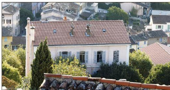
En trois ans, la commune a fait refaire la charpente, l'isolation et la toiture de l'école. (Photo F. M.)
