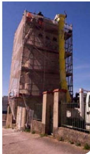
Réalisation de travaux d'enfouissement de réseaux et d'étêtement au poste de transformation HTA / BT « Essarts » à Ollioules.
